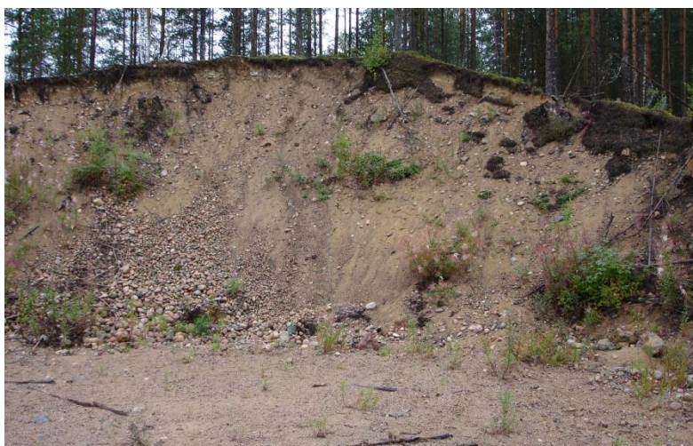
Kuva 4. Hepoharjun maa-ainesten ottoalueen valunut leikkauseinämä (17.8.2012). Kuva © Tapio Väänänen / GTK.
