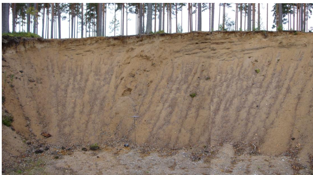
Kuva 4. Keriniemessä olevan pienen maa-ainesten ottokuopan valunutta leikkausta. Kuvat © Tapio Väänänen / GTK.
