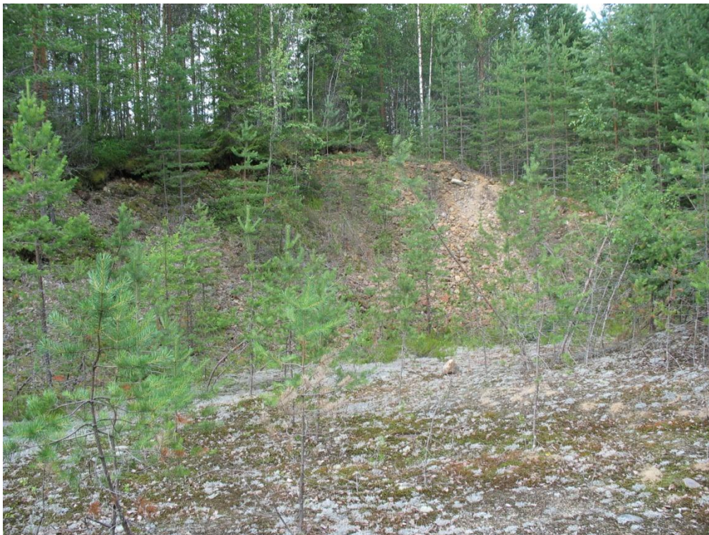
Kuva 6. Kivijärvenharjun länsipuolella sijaitsevassa selännteessä olevan vanhan ottoalueen reunan valunut leikkausseinämä (25.7. 2012). Kuva © Timo Huttunen / GTK.
