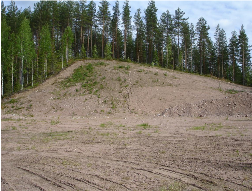
Kuva 3. Huhhilontien eteläpuolella olevan maa-ainesten ottoalueen luiskattu seinämä. Kuva © Tapio Väänänen / GTK.
