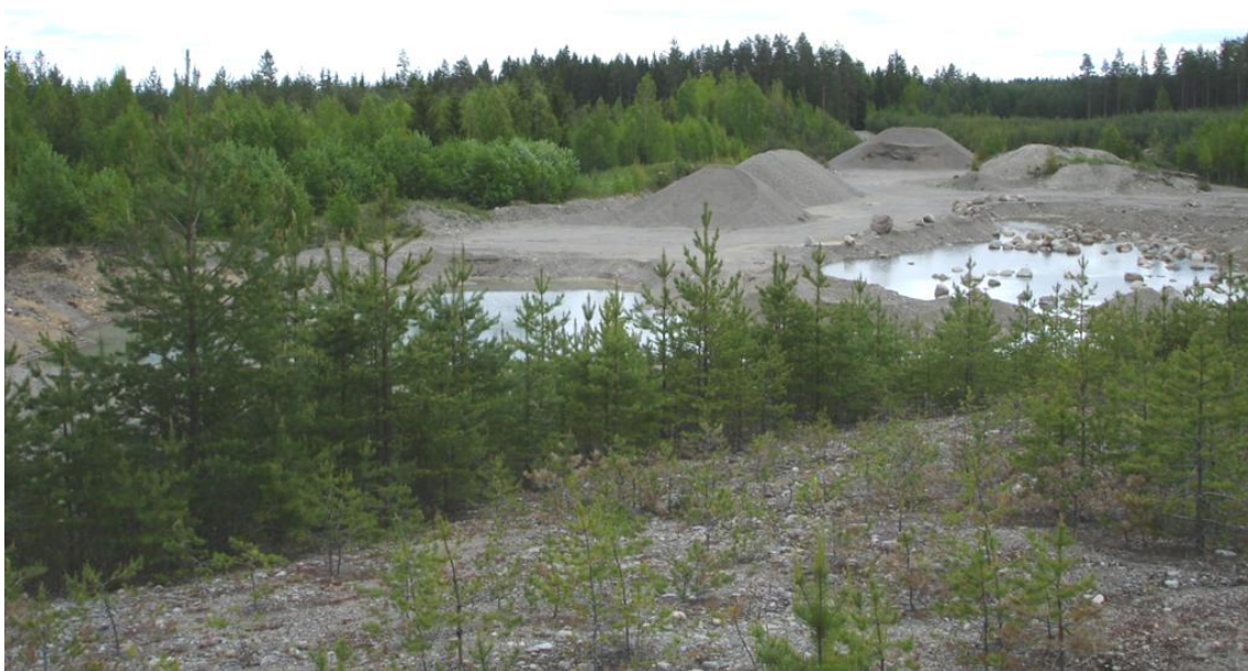
Kuva 3. Myllyharjun keskiosan maa-ainesten ottoalue, jossa kaivuuta on tehty noin metri pohjaveden pinnan alapuolelle. Kuva © Tapio Väänänen / GTK.
