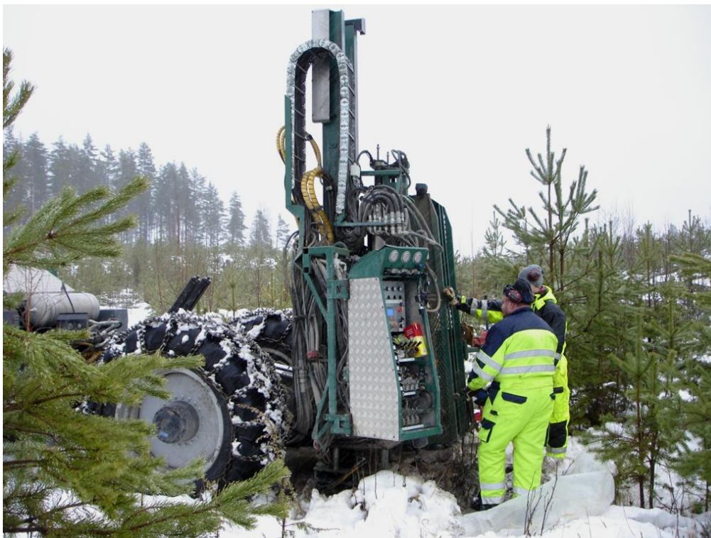
Kuva 4. Pohjavesihavaintoputken HP34-2011 asennusta raskaalla kairakoneella 13.12.2011 Myllylammen lieve- muodostumalla. Kuva © Tapio Väänänen / GTK.
