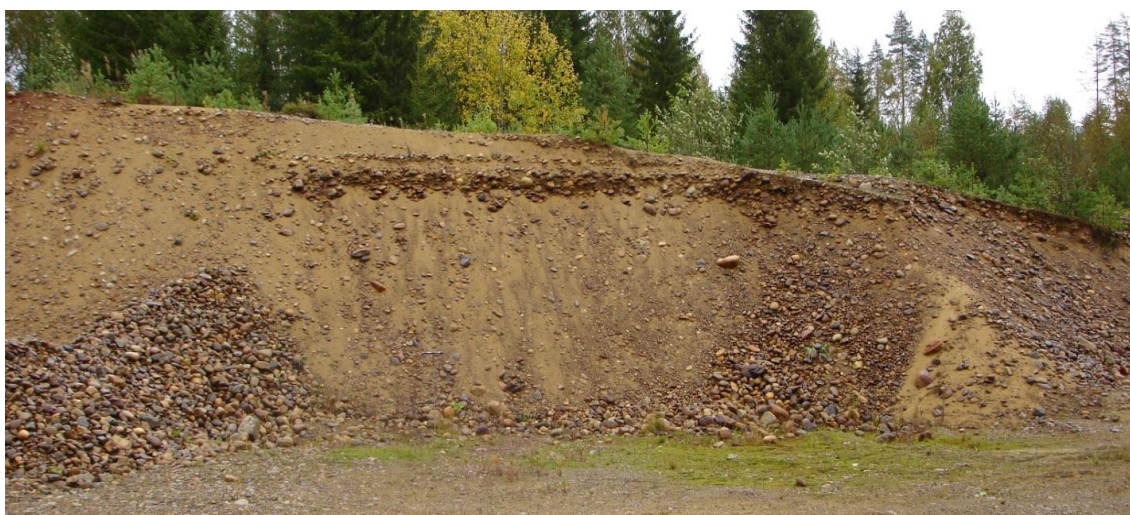
Kuva 3. Valkeajärven luoteispuolen muodostuman aines on soraa ja kivistä soraa. Seinämän korkeus on noin 3 m. Kuva © Tapio Väänänen / GTK.
