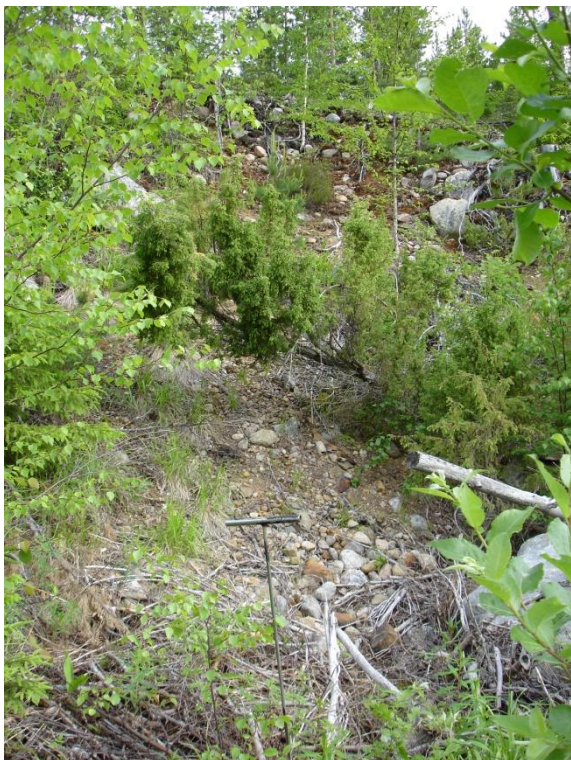
Kuva 5, Riutanmäen harjun valunut leikkausseinämä (13.6.2012). Kuva © Tapio Väänänen / GTK.
