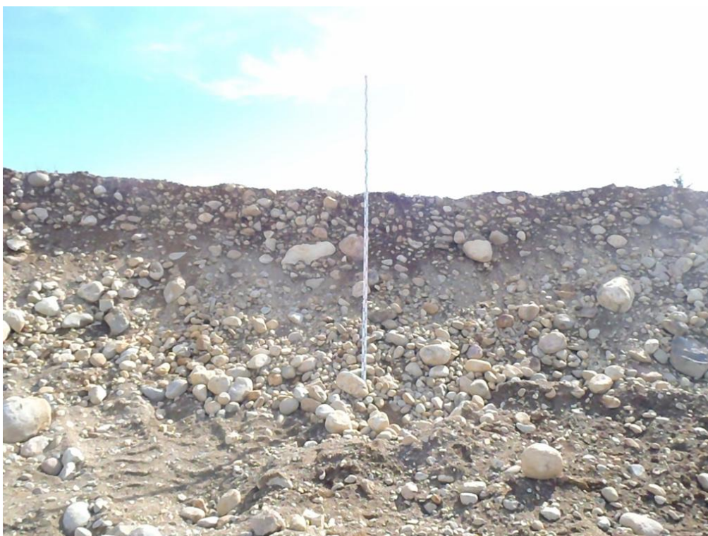
Kuva 5. Liittolahden kaivettua soraharjua. Aines oli leikkauksessa karkeaa soraa. Seinämän korkeus oli 3 m. Kuva- ussuunta etelään. Kuva © Arto Kiiskinen / GTK.
