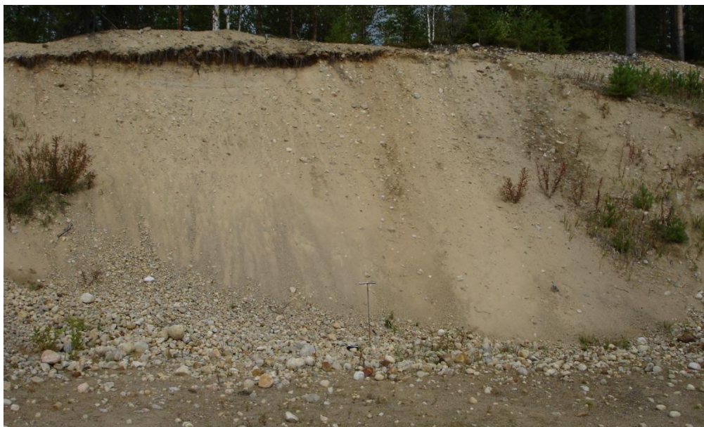
Kuva 5. Koskutjärventien varrella olevan maa-ainesten ottoalueen hiekkavaltainen leikkausseinämä (7.9.2012). Kuva © Tapio Väänänen / GTK.
