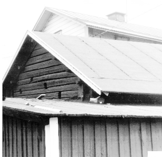
Kattohuopa on tuttu katemateriaali. Etenkin kolmiorimakate kuuluu perinteiseen rakennustapaan.
