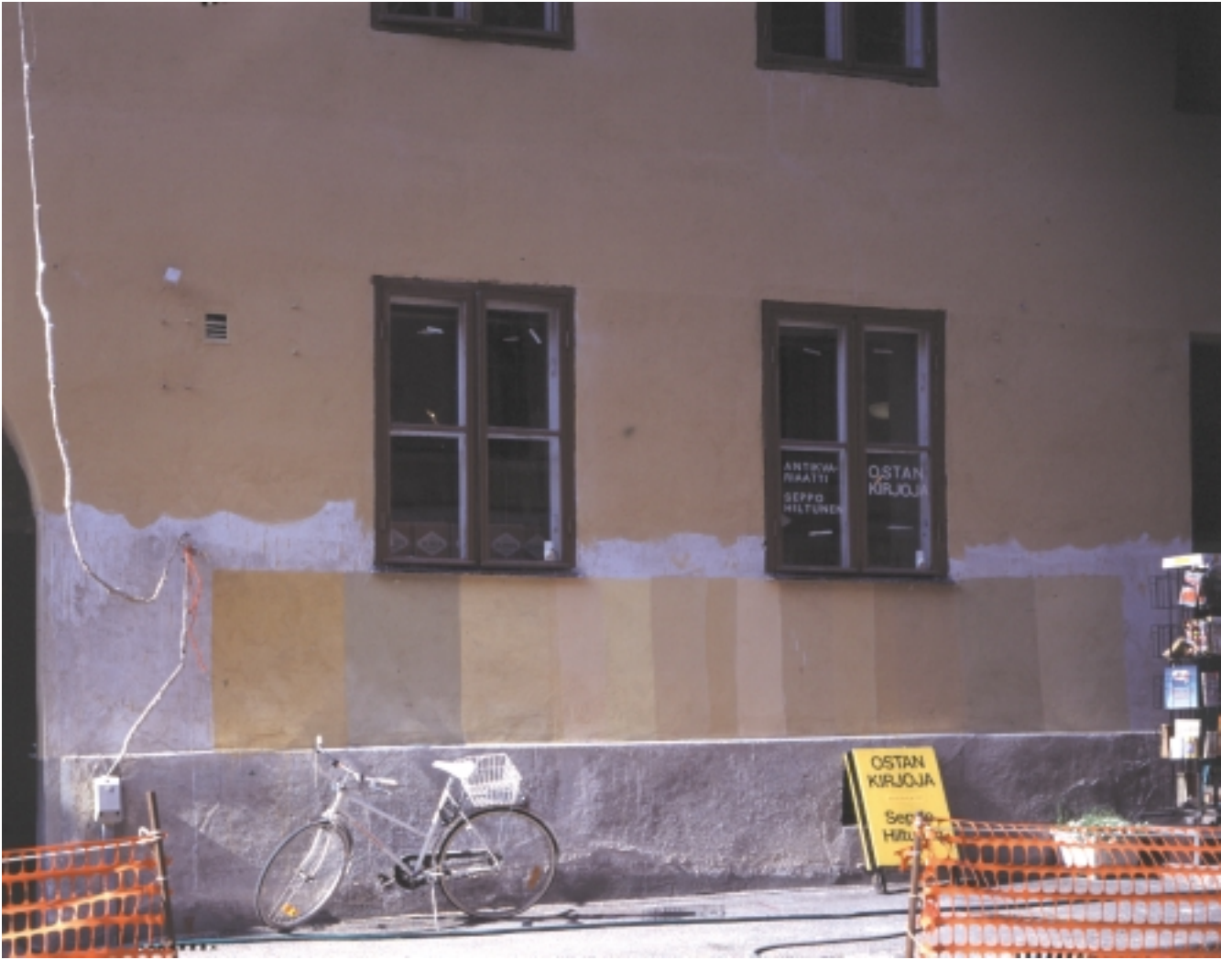
Kuva 6. Kalkkimaalaustekniikassa värimallit on tehtävä kohteeseen riittävän kauan ennen niiden värikatselmusta, koska kalkkimaali vaalenee kuivuessaan huomattavasti. Kuvassa terra- ja umbra-pigmenteillä tehtyjä värisävyille.
