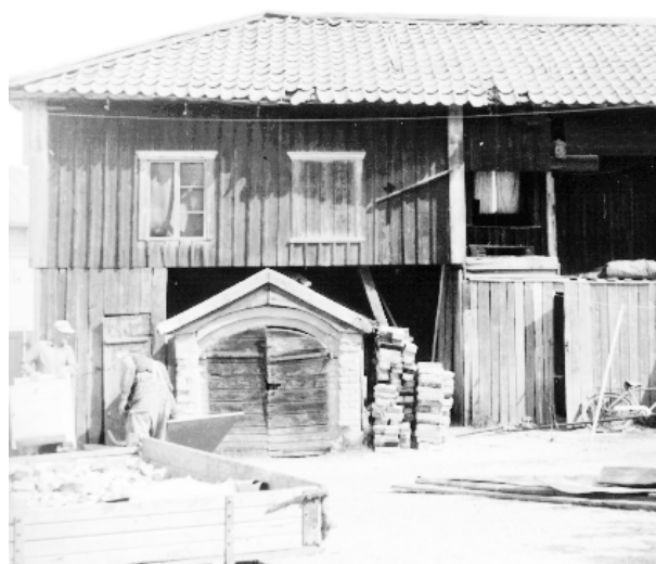
1 Etenkin merenrantakaupungeissa käytettiin katteena tiiliä, joita 1700- ja 1800-luvuilla tuotiin ulkomailta. Vanha raumalaistalo on katettu yksikouruisilla poltetuilla tiilillä. Museovirasto 1967.
