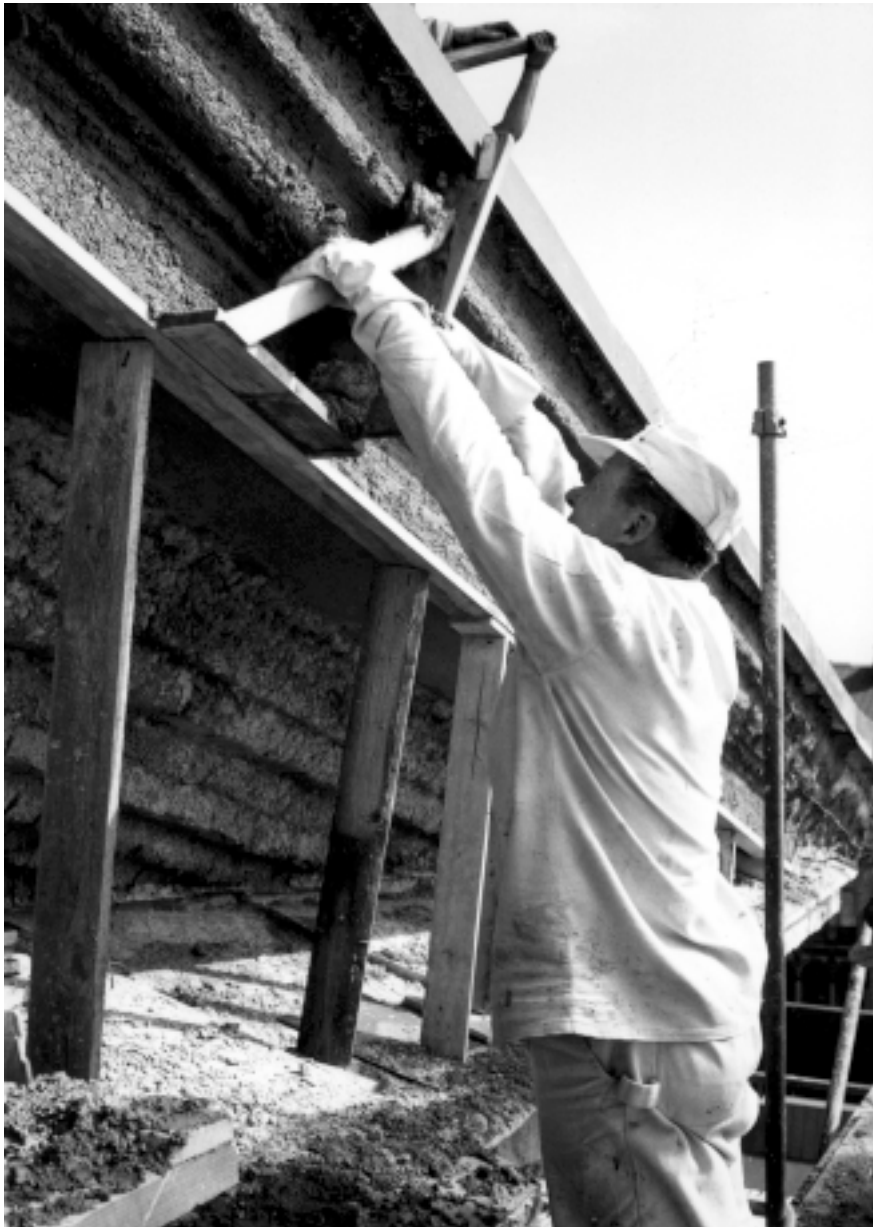
Kuva 12. Leveän profiililistan täyttörappaus käynnissä. Saplunaa pitkin listalinjaa työntämällä lista saa karkean muotonsa. Löysä hienolaasti "puristetaan" viimeistelysapluunan avulla lopullisen pinnan antavaan muotoonsa. Kaikilla arkkitehtuurikausilla on ollut omat listamallinsa ja niiden muotojen oikea tulkinta ja toistaminen uusintatyössä on tärkeä huomioida.
