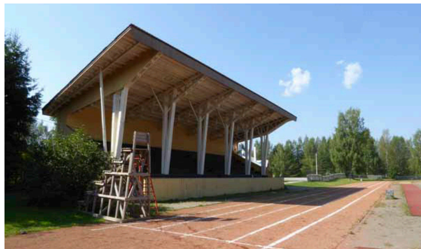
Kuvassa Savonrannan urheilukentän katsomo vuodelta 1955. Urheilukenttä on rakennettu maamiesseuran seuratalon (1923) viereen. Kuva: Laura Vikman 2014, Etelä-Savon kulttuuriperintötietokanta.
