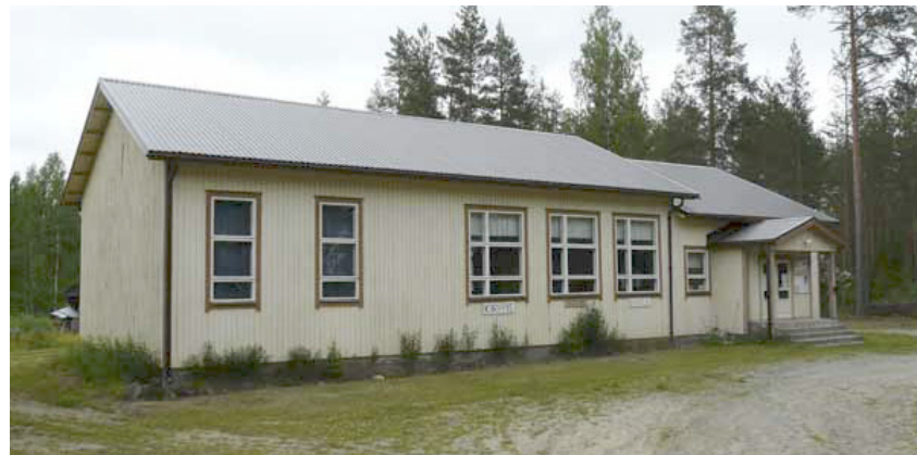
Kuvassa Enonkosken Ihamaniemen seuratalo, jonka on suunnitellut rakennusmestari Olavi Pirinen 1956. Talkootöillä valmistunut seuratalo edustaa kylien julkisen rakentamisen perinnettä. Kuva: Hanna Tyvelä 2015, Etelä-Savon kulttuuriperintötietokanta.
