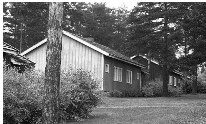
Kuvassa Savonlinnan Inkerikylän asuinrakennuksia. Alueella on arkkitehti Veikko Larkaksen, arkkitehti Erik Bryggmanin ja Puutalo Oy:n suunnittelema tyyppitaloja. Asuinalue rakennettiin vuosina 1945-46. Kuva: Kirsti Kovanen 1984, Etelä-Savon kulttuuriperintötietokanta.
