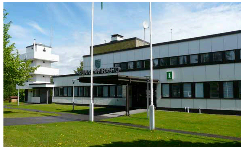
Heinäveden kunnantalo ja paloasema on valmistunut 1968. Arkkitehti Heikki Korppi-Tommolan suunnittelema rakennus edustaa kunnan julkista rakentamista sekä arkkitehtuuriltaan pelkistettyä modernismia. Kuva: Hanna Tyvelä 2015, Etelä-Savon kulttuuriperintötietokanta.
