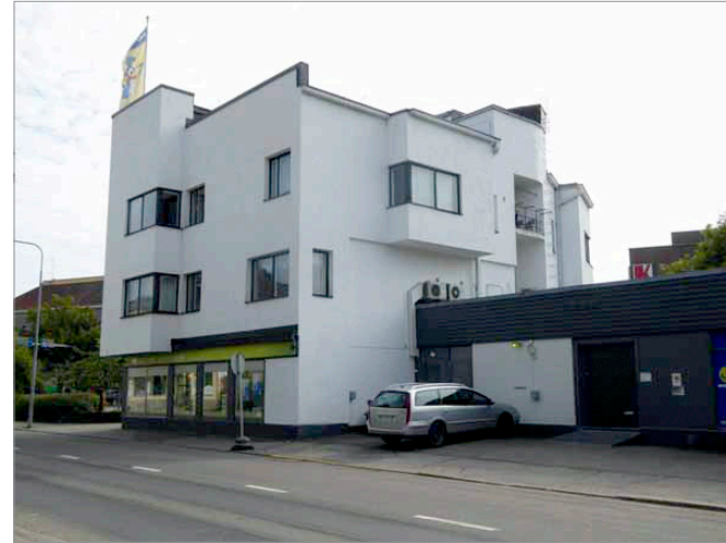
Kuvassa Pieksämäellä sijaitseva Sepposen asuin- ja liikerakennus vuodelta 1939. Arkkitehti Pekka Saareman suunnittelema rakennuksessa näkyvät funktionalismin piirteet eli vapaa julkisivu, tasakatto, nauhaikkunat (erkkereissä) ja sileä rappaus. Rakennukseen on myöhemmin rakennettu lisäsiipi.
