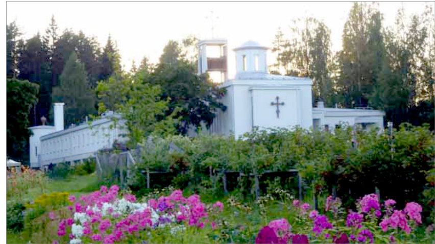
Kuvassa Lintulan Pyhän Kolminaisuuden kirkko vuodelta 1973. Lintulan luostarialueeseen kuuluvat kirkon lisäksi asuinrakennukset ja kynttilätehdas (1988). Kuva: Niina Uusi-Seppä 2014, Etelä-Savon kulttuuriperintötietokanta.
