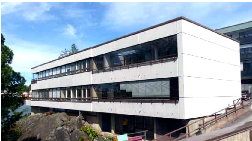
Kuvassa Savonlinnan seurakuntakeskuksen pienkerrostalo vuodelta 1972. Heikki Elomaan suunnittelemassa rakennuksessa julkisivumateriaalina on käytetty betonielementtejä. Henkilökunnalle rakennettu kerrostalo on osa seurakuntakeskuksen rakennuskokonaisuutta. Kuva: Hanna Tyvelä 2015, Etelä-Savon kulttuuriperintötietokanta.
