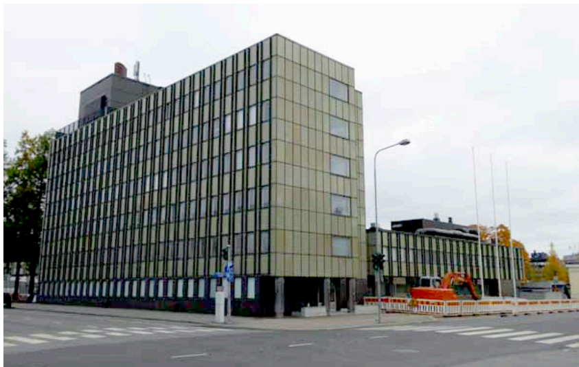
Mikkelin virastotalokorttelin uudisrakentamisen on suunnitellut arkkitehti Eero Jokilehto vuonna 1962. Kantavasta rakenteesta erillään oleva lasijulkisivu on toteutettu ns. curtain wall-idean mukaan. Kuva: Laura Vikman 2014, Etelä-Savon kulttuuriperintötietokanta.
