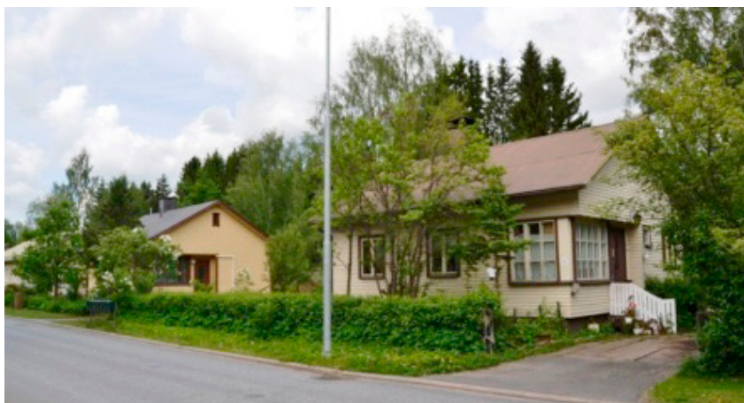
Kuvassa Mikkelin Poppelitiellä sijaitsevia A-taloja, jotka ovat A. Ahlström Oy:n ja Alvar Aallon yhteistyössä kehittämiä teollisesti esivalmistettuja tyyppitaloja 1940-luvulta. Julkisivuihin on tehty muutoksia. Kuva: Aada Mustonen 2012, Etelä-Savon kulttuuriperintötietokanta.
