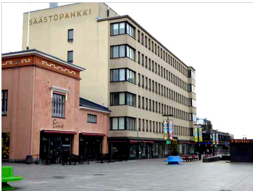
Kuvassa Mikkelin säästöpankki vuodelta 1942. Arkkitehti Martti Välikankaan suunnittelemassa funkkisrakennuksessa on käytetty terrasti- eli jalorappausta. Julkisivun terrassilla ja tummalla graniitilla haluttiin luoda vaikutelma vauraasta pankkirakennuksesta. Kuva: Laura Vikman 2015, Etelä-Savon kulttuuriperintötietokanta.
