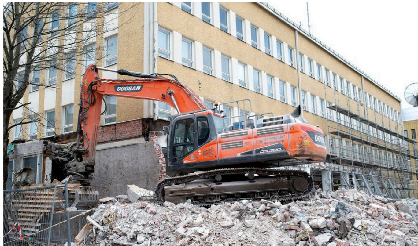
Lappeenrannan Teletalo puretaan uuden oikeustalon tieltä. Rakennus oli alueen viimeinen jäänne 1950-luvun ajalta eikä rakennuksessa todettu sisäilmaongelmia.
