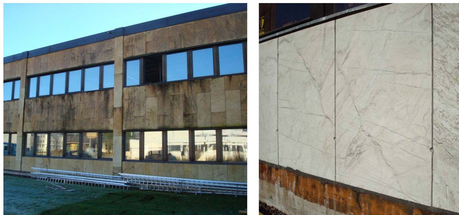
Marmorijulkisivu ennen pesutoimenpiteitä ja niiden jälkeen.
