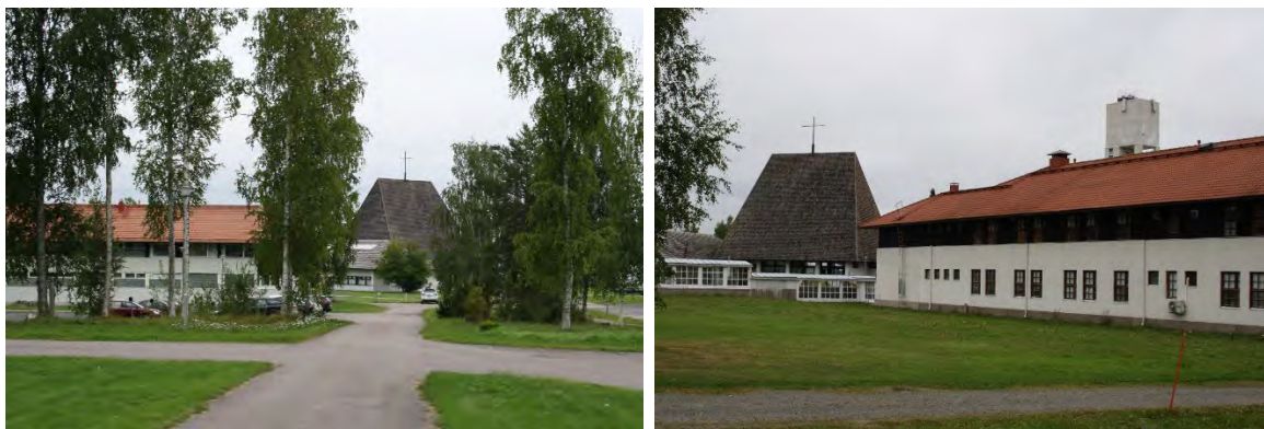
Kuva 17. Vaalijalan kuntoutuskeskuksen alueen keskellä on kirkko.
